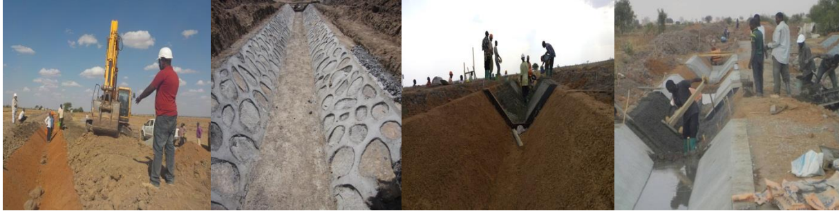
Ujenzi wa mifereji
