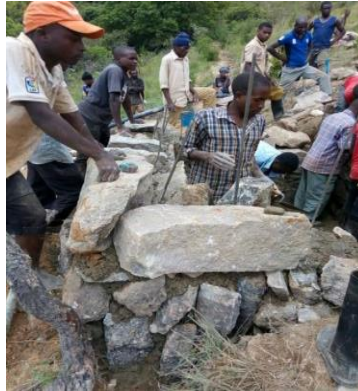
Ujenzi wa Banio
